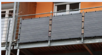
Abb 4 — Flexibles PV-Modul. Foto: Sebastian Müller
