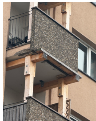
Abb 3 — Viele Balkone, die nur mit Moniereisen befestigt wurden, fangen nach 40 Jahren an zu rosten und laufen Gefahr abzubrechen. Eine Restauration ist teuer. Hier wurden die Balkone mit Balken abgestützt. •
