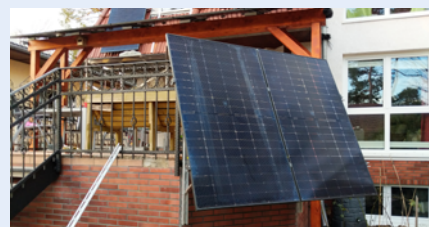
Abb 5 — Standard Modul in bifazialer Ausführung Foto: Björn Ruberg
